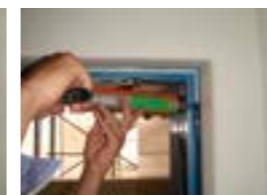
③ 新しい枠を取り付け、既存の枠との隙間をコーキング材(防水剤)で塞いでいる作業です。
