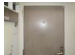
① 交換前の玄関ドアです。
