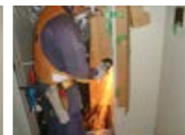
② 玄関ドア本体を取り外し、既存の枠を切り落としている作業です。
